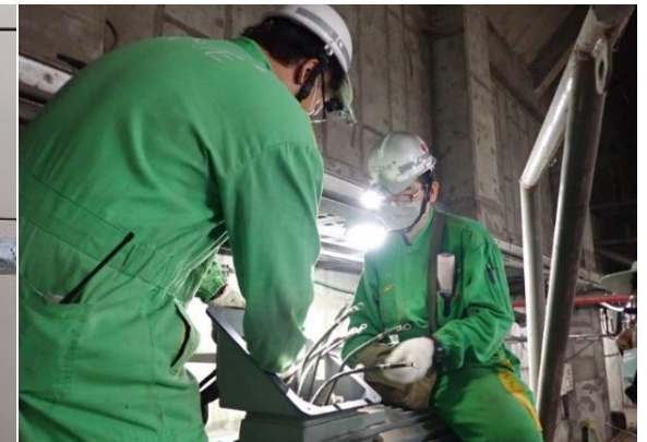
Fan Motor Replacement
